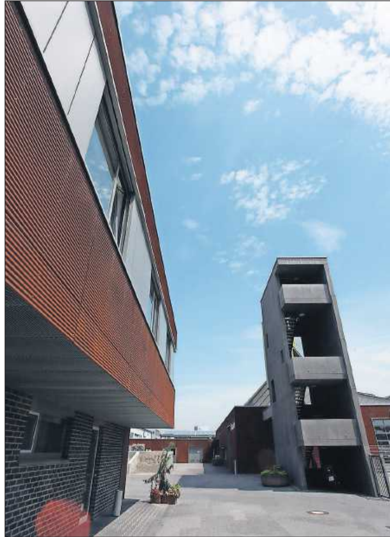
Eine rotbraune Rostfarbe ist ein prägender Faktor der Fassade des Feuerwehrhauses in Rülzheim. FOTO: VAN
